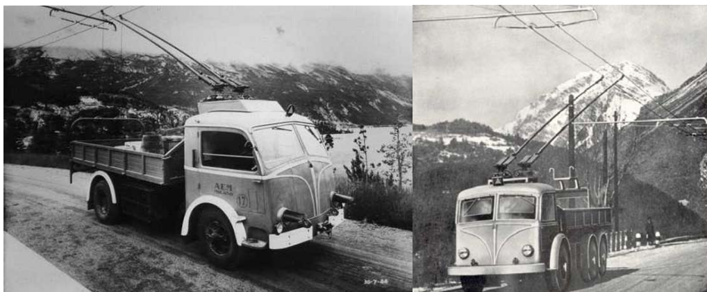
Trådlastbilar var i bruk från 1938 till 1962 i Valtellina, Italien. Totalt 20 fordon för transport av cement, sand och utrustning till byggandet av Valtellina-dammen i norra Italien
